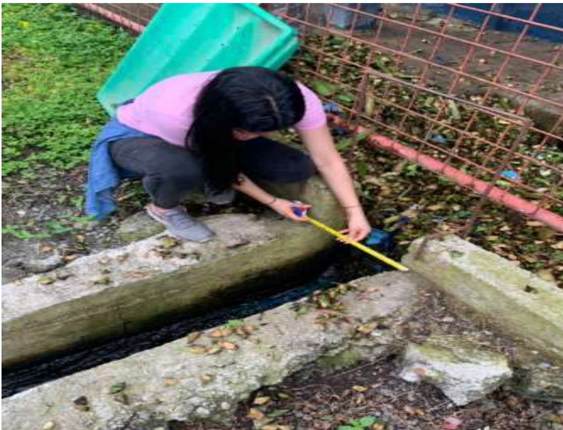
Figura 16. Medición del canal de drenaje de las tinas de lavado
